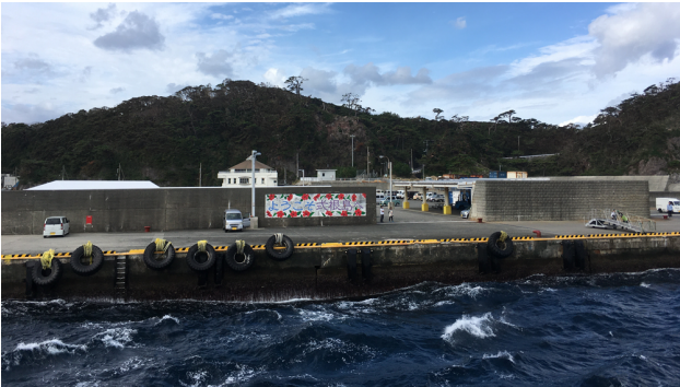
式根島の玄関口「野伏港」。防波堤には「ようこそ式根島へ」のイラストが
